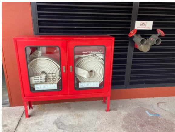
รูปที่ 2-29 ตู้เก็บสายน้ำดับเพลิงชั้นตาดฟ้า
