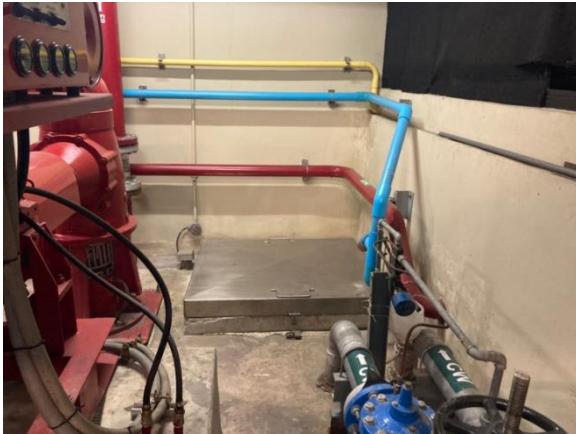
รูปที่ 2-33 ถังเก็บน้ำใช้และน้ำดับเพลิงชั้นใต้ดิน
